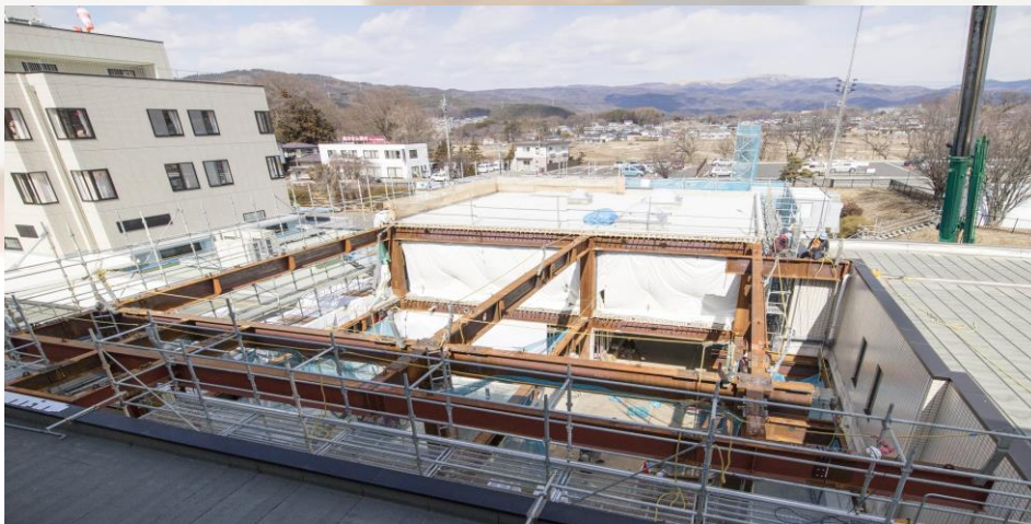
鉄骨が建ち上がる北低層棟
