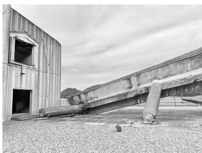
石巻市立大川小学校を襲った巨大津波。校舎と体育館をつなぐ渡り廊下
